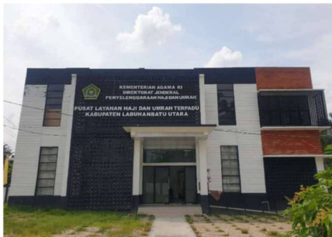
Gambar 3.11 Gedung PLHUT Kankemenag Kabupaten labuhanbatu Utara
