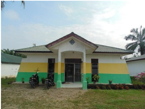
Gambar 1.2. Gedung lama Kementerian Agama Kabupaten Labuhanbatu Utara
